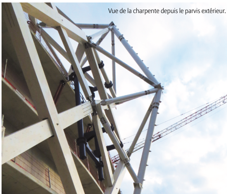
Nœuds de la charpente bois et pyramides en métal.
